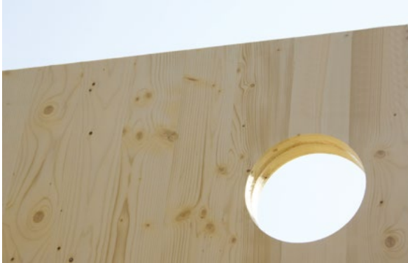
Fresatura di fori circolari.
