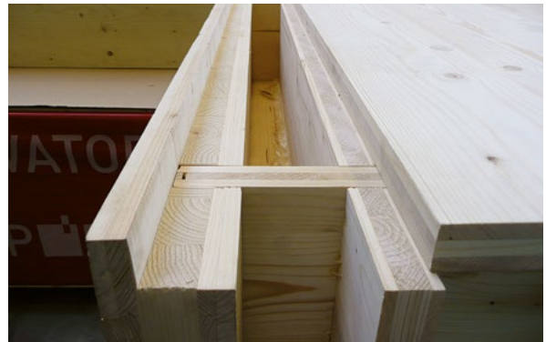
Chiusura del taglio a vista con un pannello massiccio.
