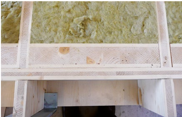
Rinforzo nel punto della pressione con legno massiccio.
