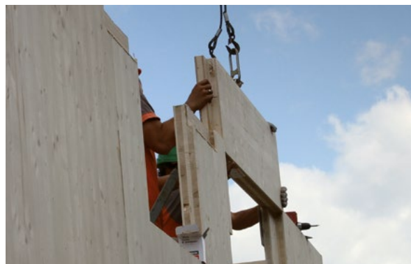
Preparazione dei giunti e infissi – SOLID 84, 124 mm.
