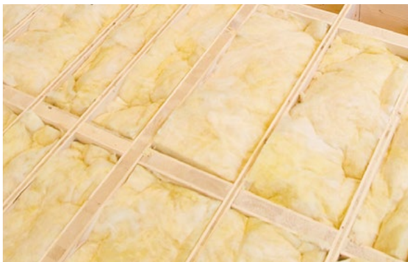
Completamento con isolamento minerale.
